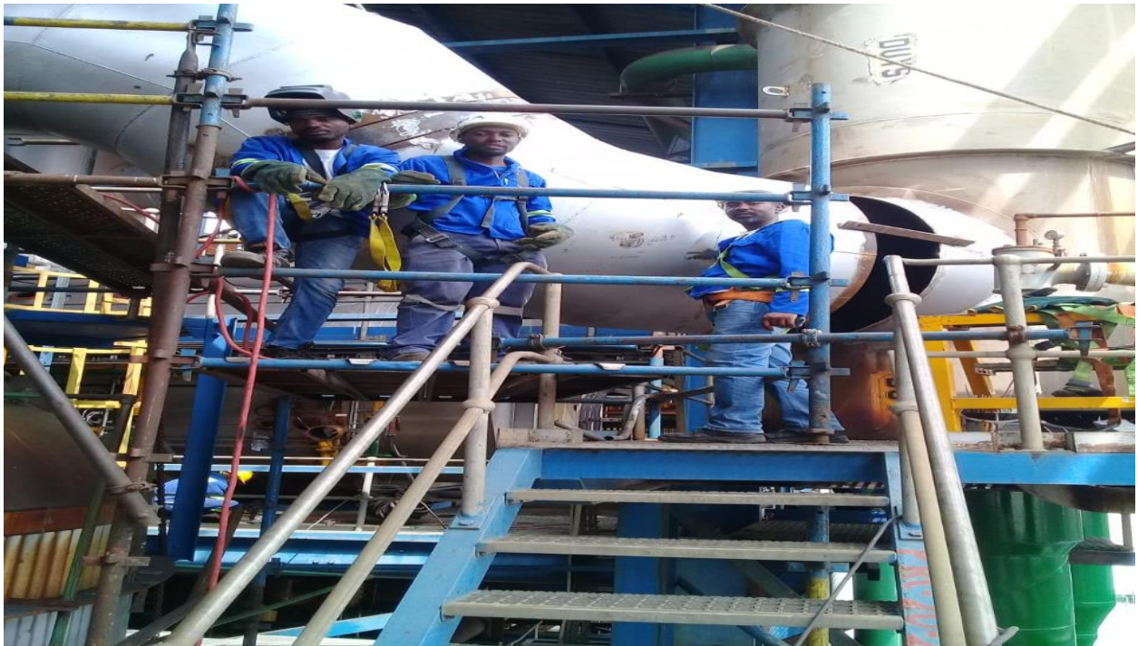
Montagem de tubagem de conduta
