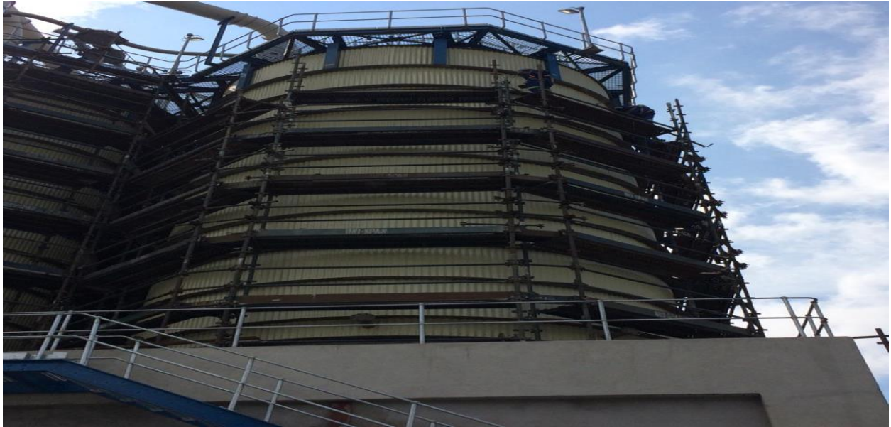
Soldadura e auxílio na montagem de Silos
