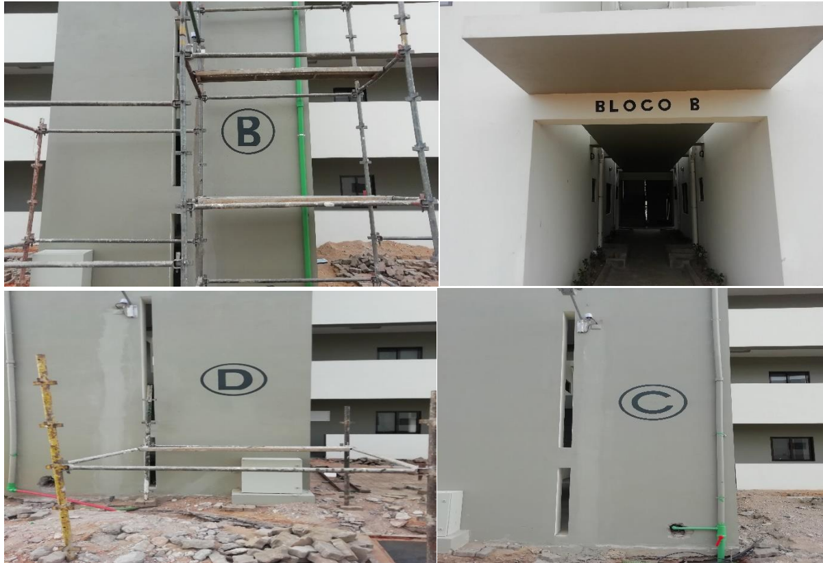
Pintura e demarcação dos edifícios e estacionamento de carros
