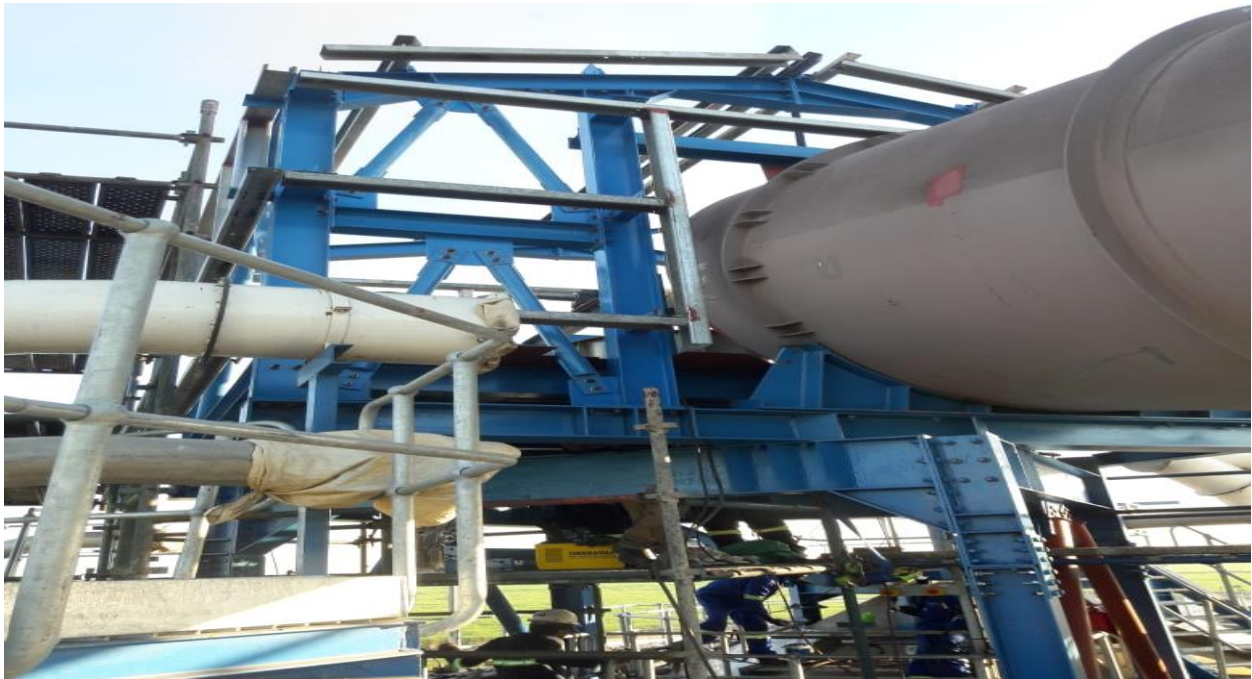
Soldadura de bims e tubagem
