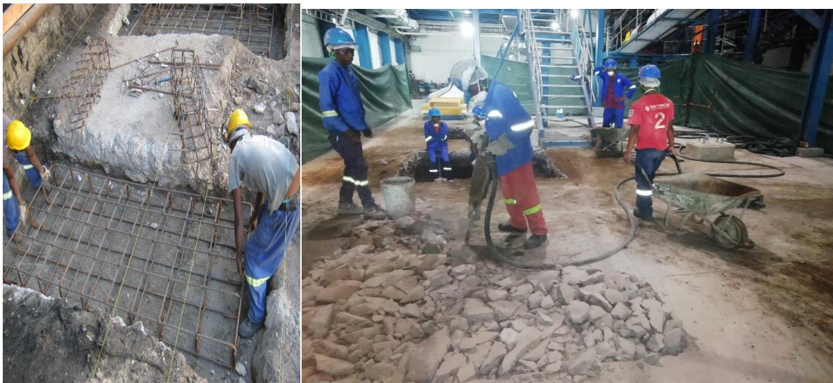
Construção de bases de suporte de Bims
