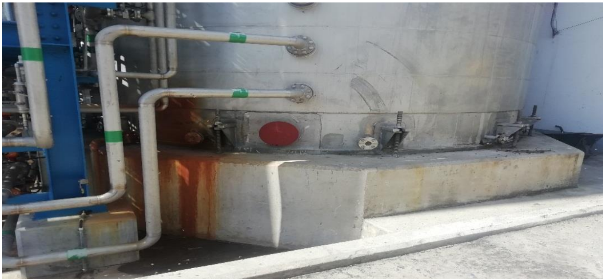
Montagem de tubagem no tanque cristalizador
