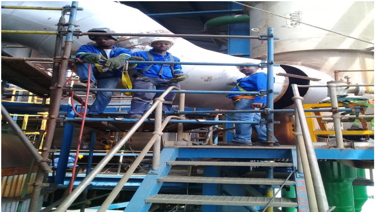
Montagem de tubagem de conduta
