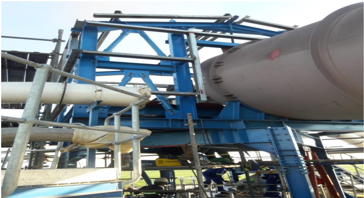
Soldadura de bims e tubagem
