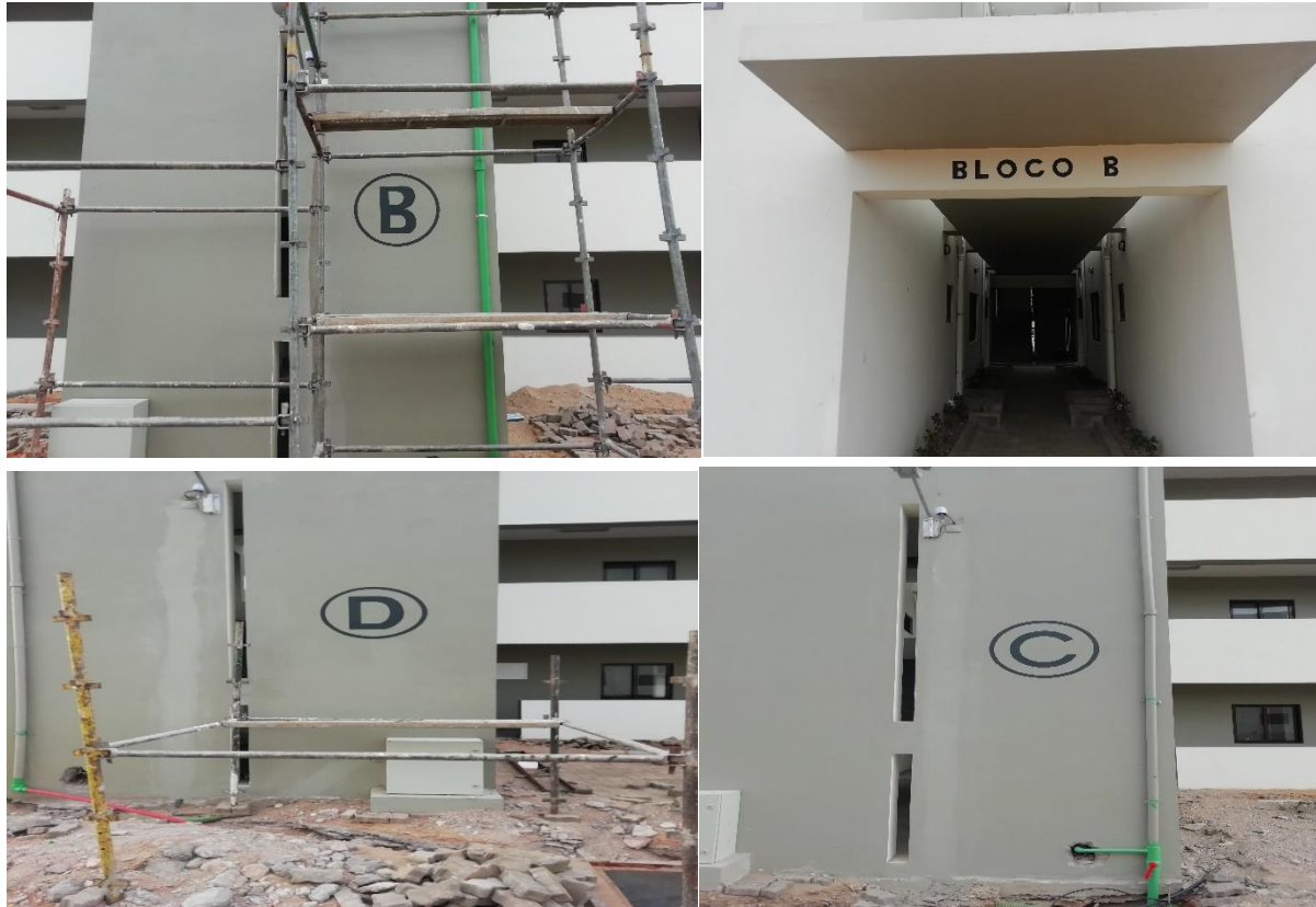
Pintura e demarcação dos edifícios e estacionamento de carros
