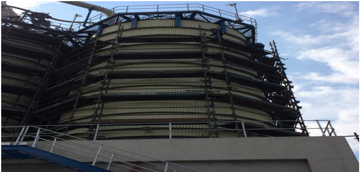
Soldadura e auxilio na montagem de Silos
