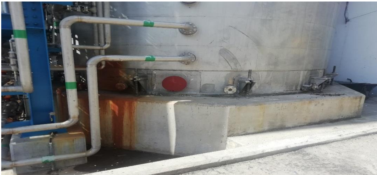
Montagem de tubagem no tanque cristalizador
