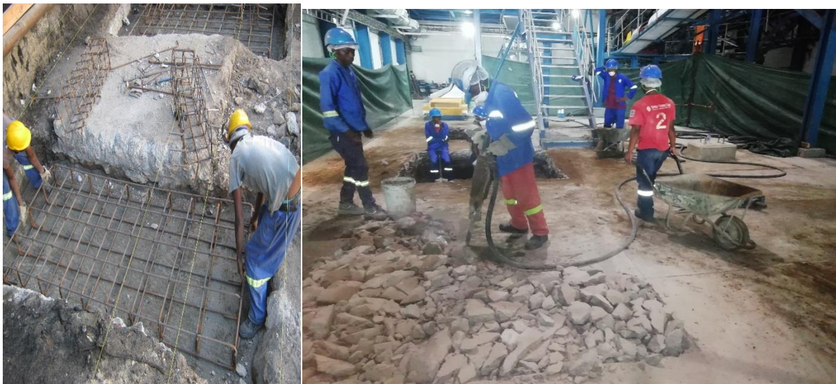
Construção de bases de suporte de Bims
